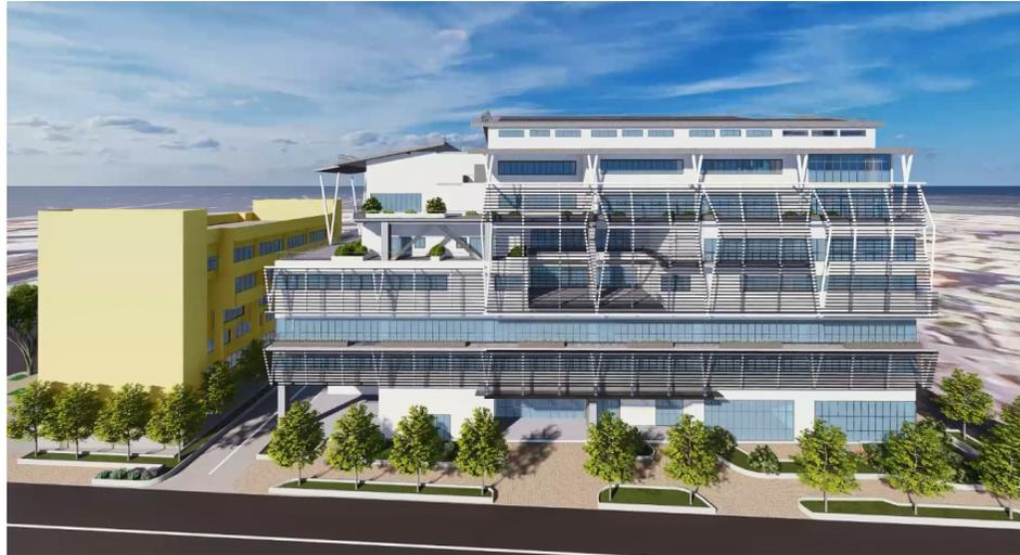
本案位於臺中市豐原區，由台灣電力股份有限公司輸變電工程處中區施工處規劃興建，預定作為辦公大樓使用。建築規模為地下3層、地上7層，其中地下樓層採鋼筋混凝土（RC）結構，地上樓層則採用鋼骨結構，總樓地板面積約為6,155坪。
