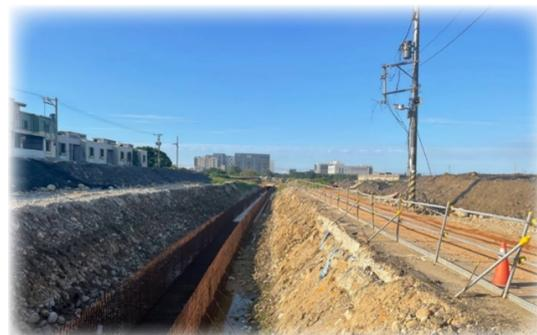
↑ 施工作業採取適當的防護避免環境汙染，材料暫置有適當覆蓋
