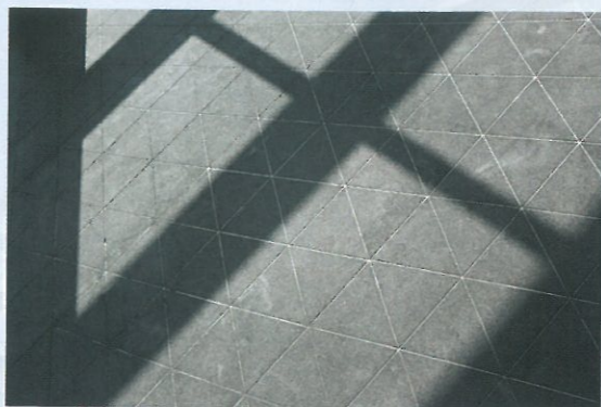
地板也是工藝 安藤忠雄評為「比日本還要精準」的石材工藝，由一塊塊梯形石材拼出一樓大廳的三角形地板。
